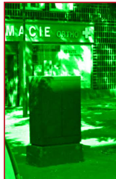
EXEMPLE D'ARMOIRE À FEUX
